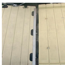
Bevestiging van de loopbrug aan de steiger
