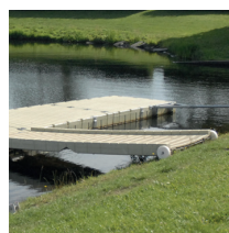
Systeem van wielen voor loopbrug
