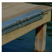
Bevestiging van de loopbrug aan de oever
